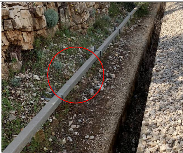
Canalina metallica porta cavi
